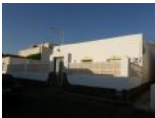
Vista General Casa
